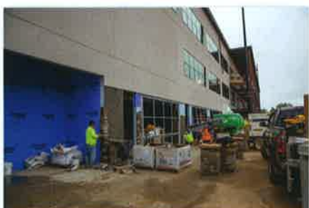
Baustelle Pressezentrum: Zwar funktionierte die Technik (die Hauptsache), aber Toiletten wären auch schön gewesen.
